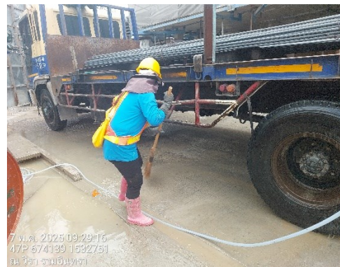
รูปที่ 6 พื้นที่ล้างล้อรถบรรทุก
