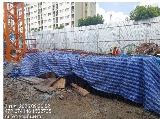
รูปที่ 8 การปิดคลุมวัสดุก่อสร้าง
