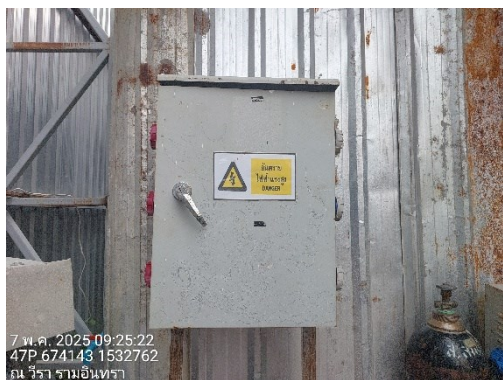
รูปที่ 13 อุปกรณ์จ่ายไฟฟ้าชั่วคราวภายในโครงการ
