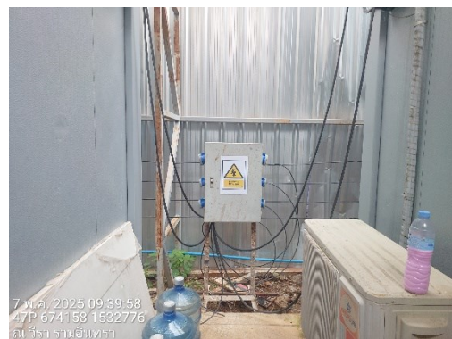
รูปที่ 13 อุปกรณ์จ่ายไฟฟ้าชั่วคราวภายในโครงการ
